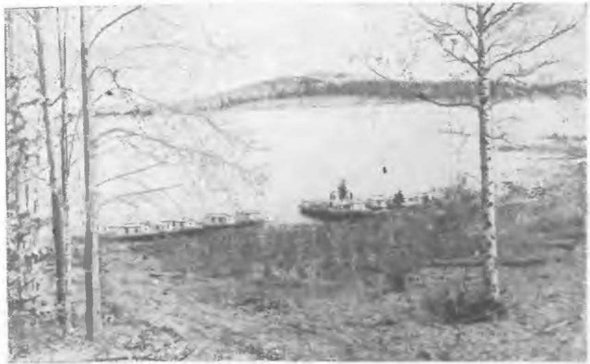
Рис. 8. Шламоотстойный пруд (1962 г.) — шламохранилище емкостью 360 млн. м<sup>3</sup>, рассчитанное на 35 лет работы комбината.
