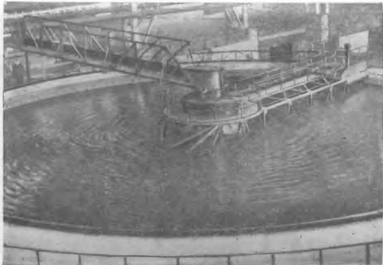
Рис. 25. Сгуститель пульпы, содержащей железо-ванадиевый концентрат.
