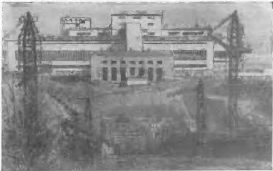
Рис. 21. Вид на построенный корпус среднего и мелкого дробления. На переднем плане внизу виден котлован и фундамент корпуса крупного дробления; за ним виден построенный корпус приводных станций.
