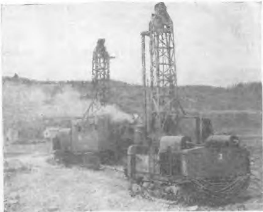
Рис. 11. Станки шарошечного бурения БСШ-1. Основные параметры станка:
